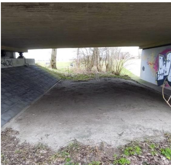
Onderdoorgang viaduct gezien van zuid naar noord.
